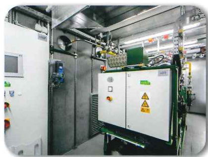
水素発電設備 agenitor 406 (コンテナ内)
