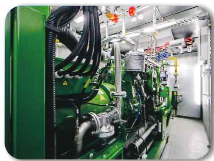
水素発電設備 agenitor 406 (コンテナ内)
